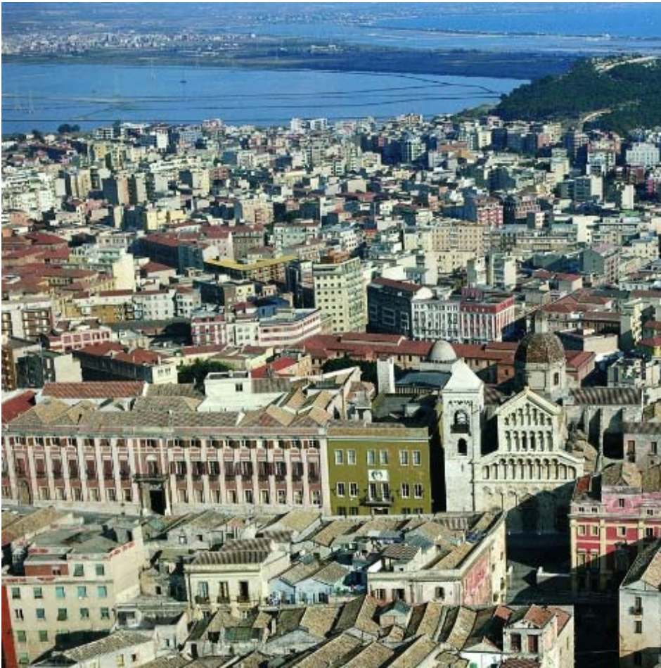
Cagliari: veduta aerea del Palazzo Reale oggi
