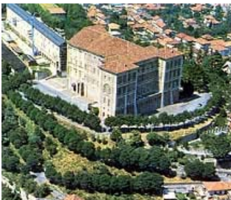
Veduta aerea del Castello di Rivoli
